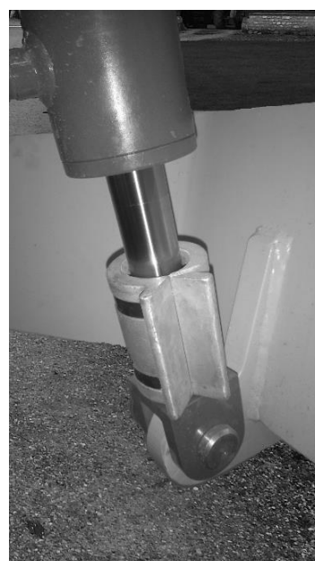
Fig. 3 : Jeu de cale installé sur vérin
